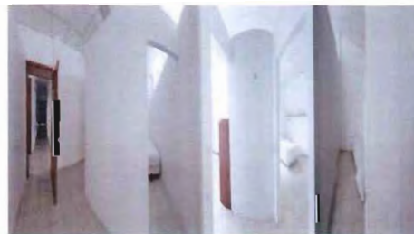
Habitaciones improvisadas con medio muro de tablaroca y sin brindar privacidad a la familia.
